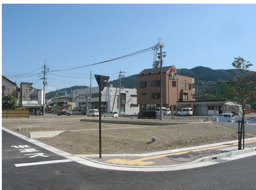
第1ゾーンの完成状況
