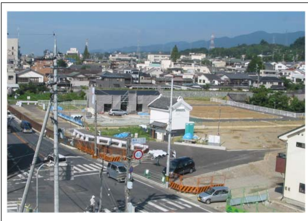
ゾーンの工事状況
