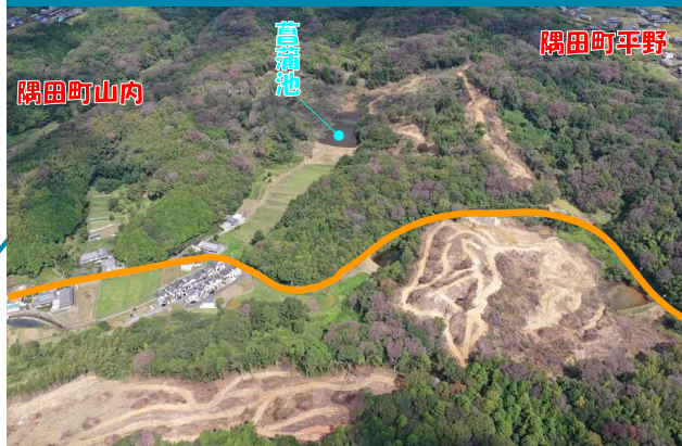
2号調整池付近を撮影
